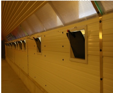
Unterdruck-Lüftung
